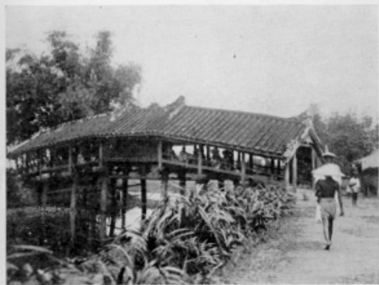
Planche LXII. — Le pont de Thanh -Thủy, face est ( en haut ). — Le pont de Thanh -Thủy face Ouest ( en bas ).
